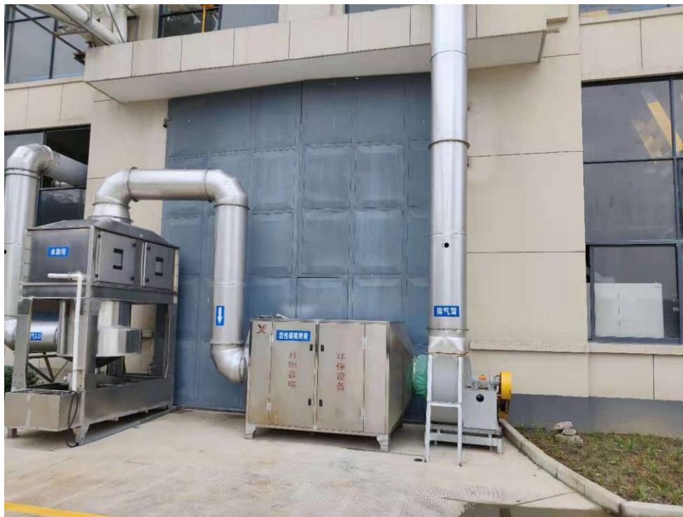
图 4-6 烘干废气处理装置
