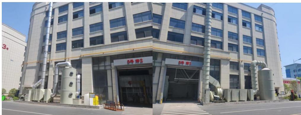
图 4-8 喷涂烘干固化废气处理设备图
